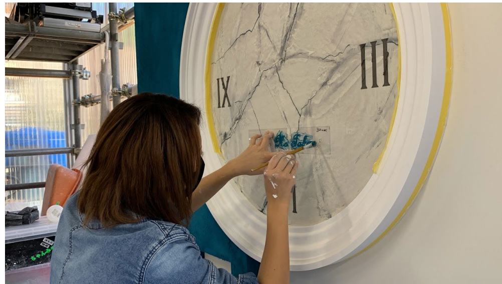
自由課題部分の文字盤をステンシル施工
