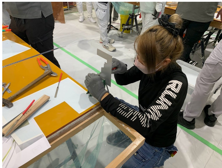
置引き工法の引き型を加工している様子
