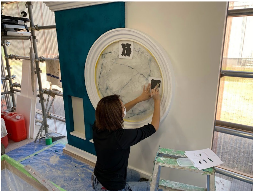
自由課題部分の文字盤をステンシル施工
