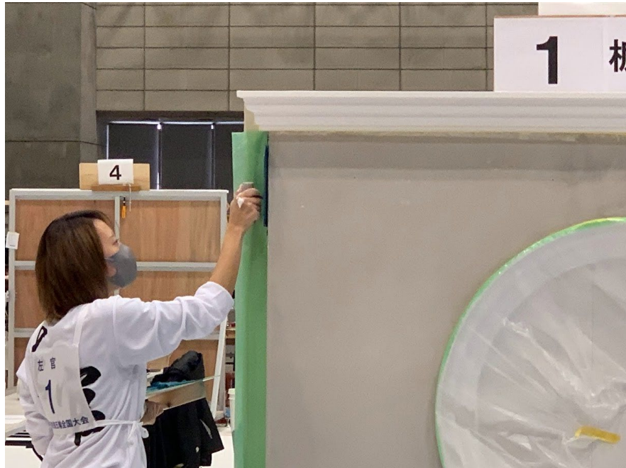
側面下地石膏塗りの様子
