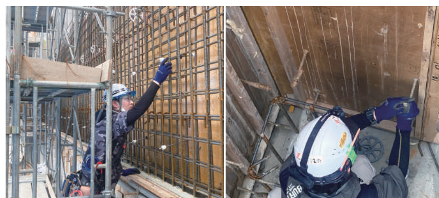
多能工の育成-型枠大工
