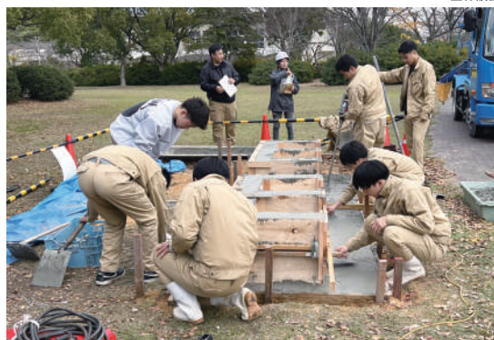
コンクリート打設
